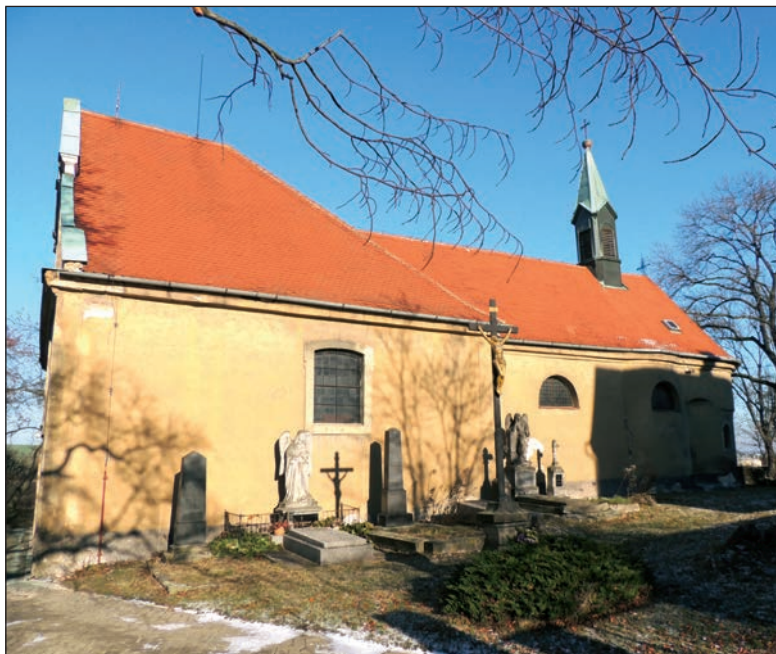
■ Obr. 1: Kostel sv. Mikuláše ve Vrapicích
