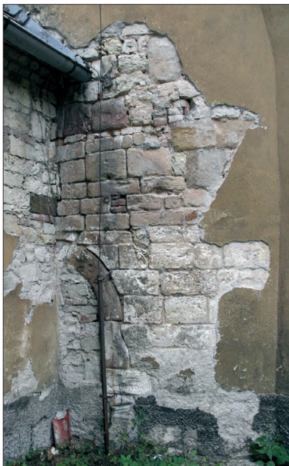
■ Obr. 2: Kostel sv. Mikuláše ve Vrapicích – románské zdivo
