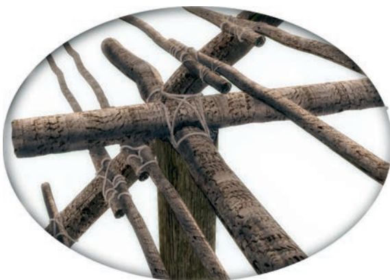
■ Obr. 2. Detail vazby trámové konstrukce.
