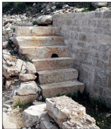
■ Obr. 9 Burnum – detail schodiště u východního vstupu
