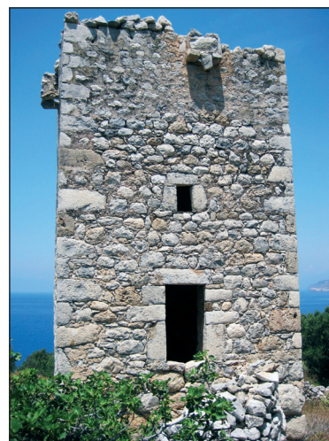
■ Obr. 9 Peloponés, Mani, usedlost u Fimalotos, věž, pohled od jihovýchodu. V horním patře střílny s výstřelem do předpolí a k patě stavby, upravené pro novověké ruční palné zbraně. Foto J. Anderle 2011.
