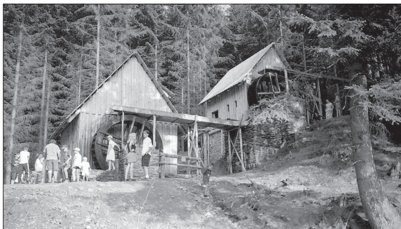
■ Obr. 8 Replika zlatorudného mlýna ve Zlatých Horách. Nahoře budova stoupovny a pod ní mlýna. Foto autor.
