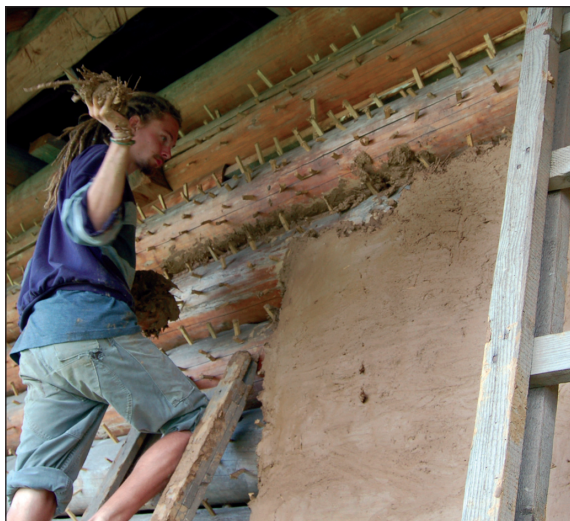
■ Obr. 5: Archeopark Praha-Liboc. Omazávání vrchní části roubené stěny (první vrstva omazu; foto P. Netolický).
