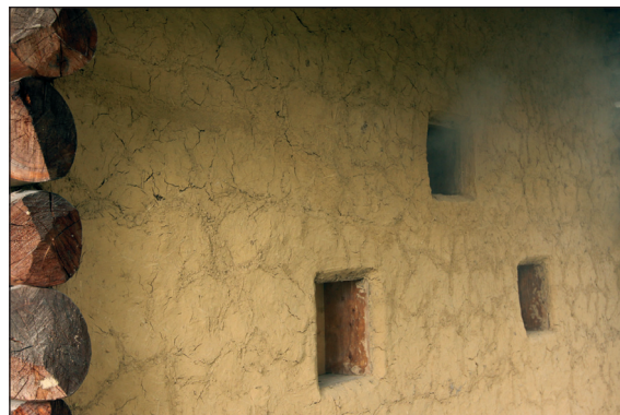
■ Obr. 8 Archeopark Praha-Liboc. Detail štítové stěny opatřené omazem s pyramidovitě uspořádanými okny v jizbě; horní slouží k odvodu dýmu, jak je patrné na záběru během testování dýmného provozu (foto P. Vařeka).
