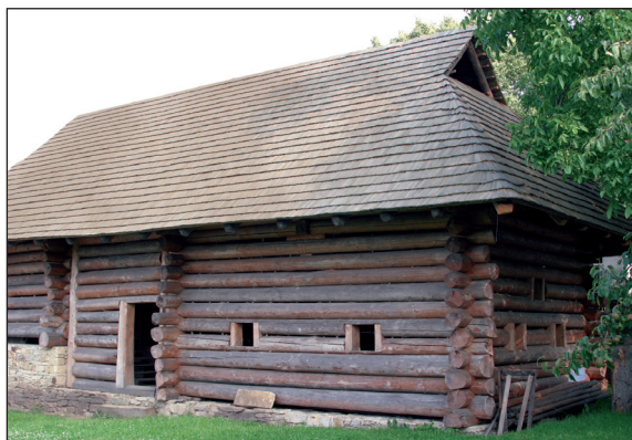
■ Obr. 1 Archeopark Praha-Liboc. Trojdílný roubený dům před omazáním. V přední části dýmná jizba, dále střední síň a vzadu patrová komora se spodní částí zapuštěnou vyzděnou částí (foto P. Vařeka).
