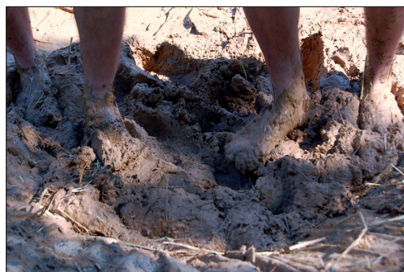
■ Obr. 3 Archeopark Praha-Liboc. Příprava mazanice šlapáním sprašové hlíny s příměsí slámy a sena (foto P. Netolický).
