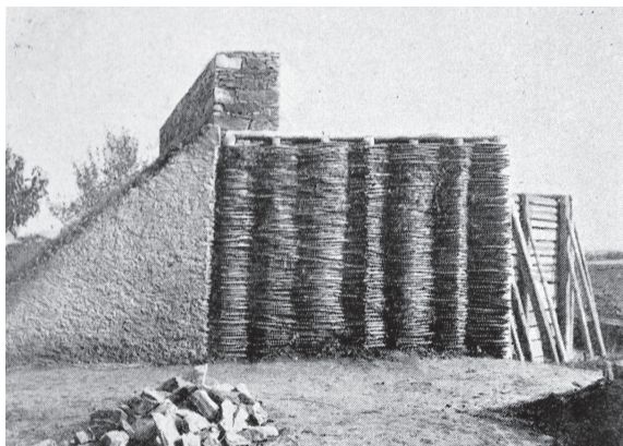
■ Obr. 8 Fotografie rekonstrukce brány 1 : 1 na Staré Kouřimi (Šolle 1953, 358)
