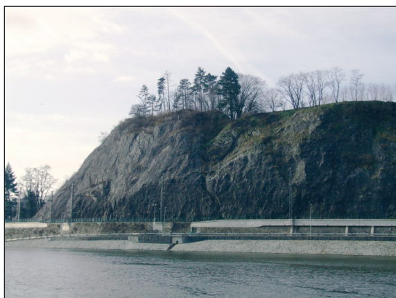
■ Obr. 9 Liběhrad, okr. Praha-západ. Částečně odlámané skalnaté zakončení ostrohu s pozůstatky hradu. Pohled od severozápadu z pravého břehu Vltavy.
