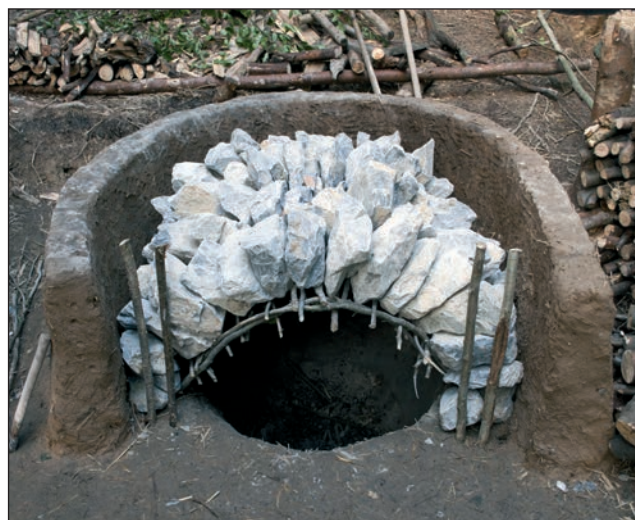
■ Obr. 9 Vyskládaná klenba vápencových kamenů.
