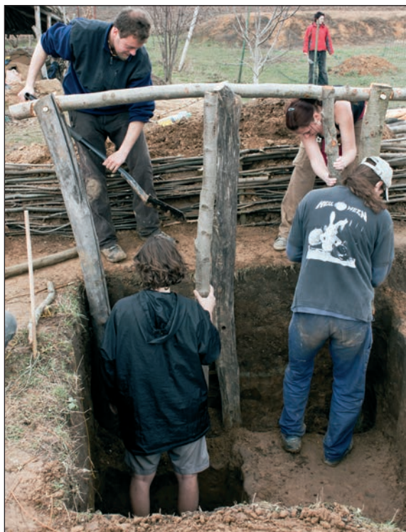
■ Obr. 8 Vztýčování nosné konstrukce přístřešku (foto J. Štěrba).
