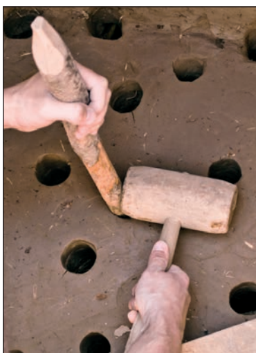
■ Obr. 12 Hutnění roštu dřevěnou palicí.
