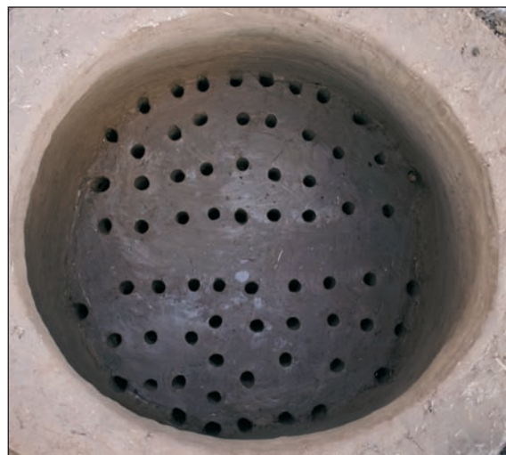
■ Obr. 13 Rošt pece po dokončení.
