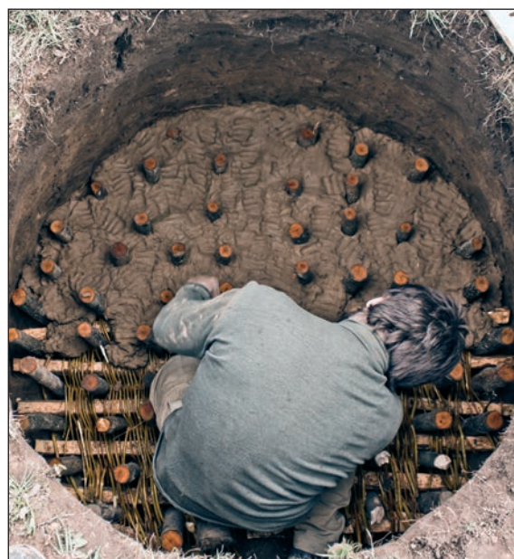
■ Obr. 11 Kladení hlíny na armaturu roštu (foto J. Štěrba).
