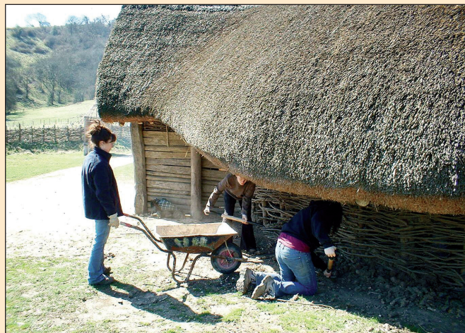
■ Butser – oprava stěn velkého kruhového domu
