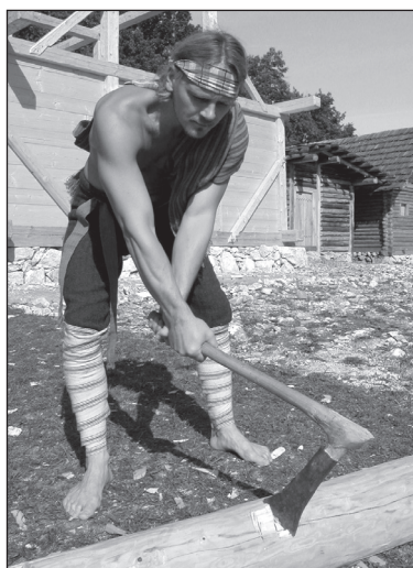
■ Obr. 4A Kácení a opracování dřeva bylo prováděno kovovými sekerami upevněnými na přírodně vyrostlé „kolenovité“ větvi jasanu a buku. B Stavební části obytného domu byly tvarovány pravoúhle pomocí teslic. C Obytný dům: čepy a zářezy byly zhotoveny dlátkem.
