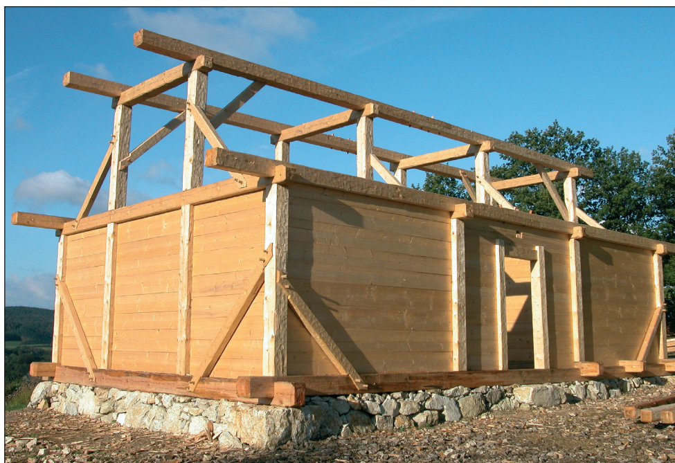
■ Obr. 6 Obytný dům: Základové trámy a pravoúhlé trámy, vertikální prkenné stěny a kostra krokví. Povšimněte si diagonálních podpěr v rozích.
