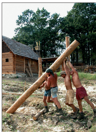
■ Obr. 7 A Kůly pro stáj byly umístěny do děr v zemi. Vztyčili jsme je ručně. B V domě zpracovatele dřeva byl postaven soustruh na výrobu dřevěných nádob, jako jsou mísy a talíře. C Během Keltského festivalu ve Schwarzenbachu se předvádějí keltská řemesla.
