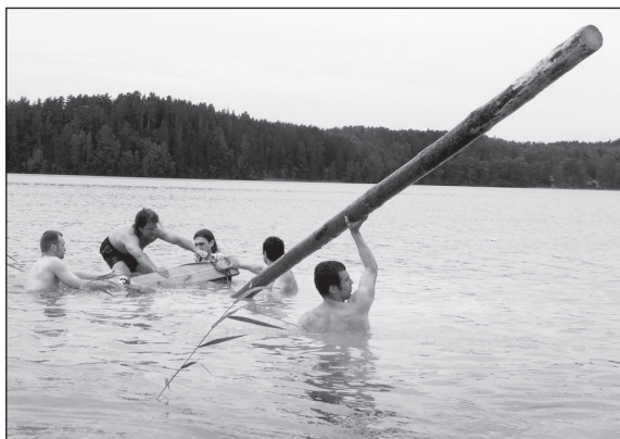
■ Obr. 13a Vztyčování dřevěné konstrukce a pilotu do vertikální polohy
