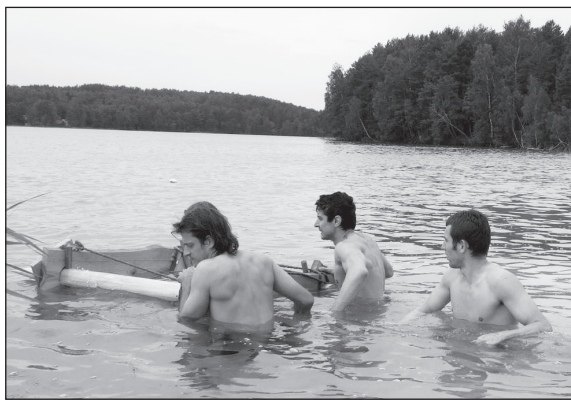
■ Obr. 12 Otáčení dřevěné konstrukce horizontálně a zasouvání pilotu, který měl být zaveden do dna
