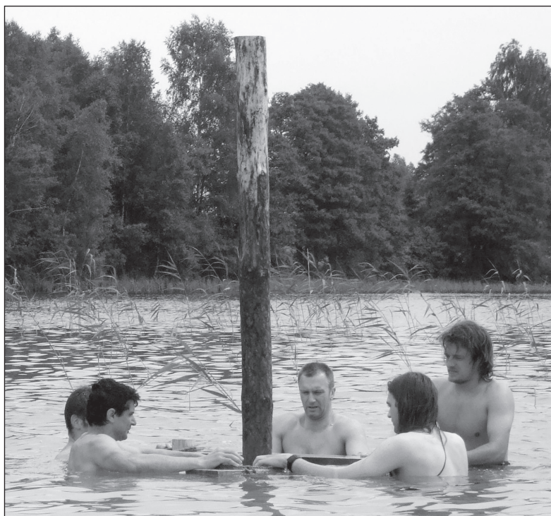
■ Obr. 17 Dřevěná konstrukce je částečně rozmontována a oddělena od zavedeného pilotu
