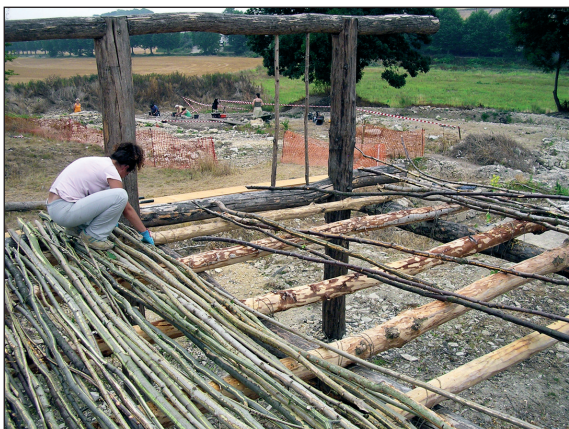
■ Obr. 7: Položení podlahy.
