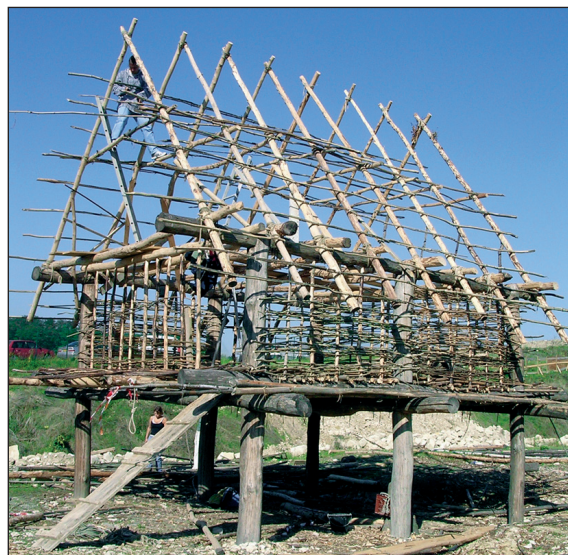
■ Obr. 12 Položení střešních latí a výplet stěn.
