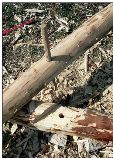
■ Obr. 10 Zakolíkování (začepování) dřev.
