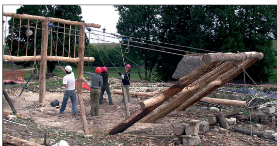
■ Obrazová příloha 1: 1-7: zvedání dřevěné stěny.
