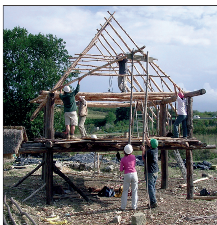
■ Obrazová příloha 2: 1-12: umístění pevné vazby střechy.
