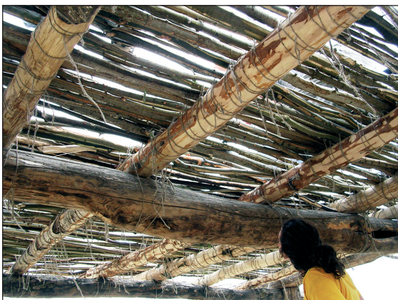
■ Obr. 8: Pohled pod podlahu.
