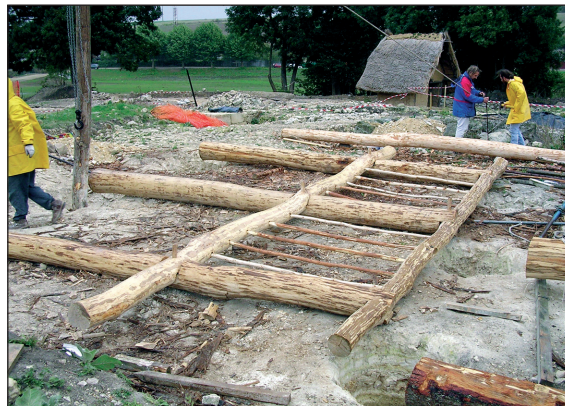
■ Obr. 5: Dřevěná stěna sestavená na zemi.
