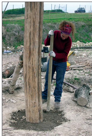
■ Obr. 6: Zасыпání hlinou.
