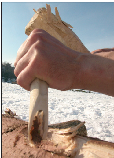
■ Obr. 10 Na úpravu zářezů, které brání krokvím v pohybu, jsme použili kromě kamenných nástrojů i dlátka z jeleních kostí.
