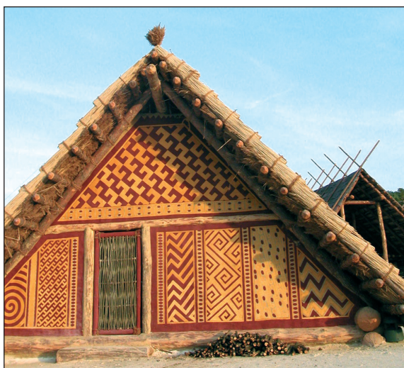
■ Obr. 11 Dům č. 1 srubové konstrukce s typickými dobovými dekoracemi na hliněné stěně; dům č. 2 kůlové konstrukce v pozadí. (Obr. 1, 2 W. Neubauer; 3, 4, 6, 7, 9, 10, 11 W. Lobisser; 5, 8 H. Humberger.)
