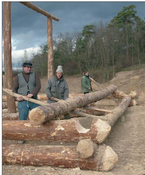
■ Obr. 8 Vnější zdi domu č. 1 byly postaveny srubovou technikou.
