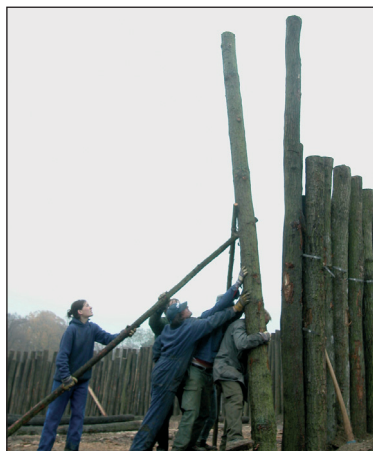
■ Obr. 4 Palisádové kůly byly vztyčeny ručně.
