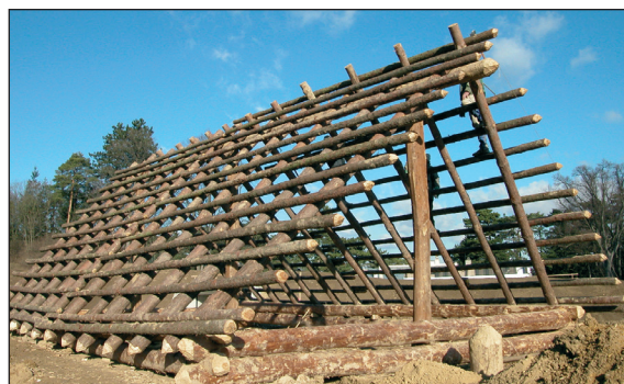
■ Obr. 9 Dům č. 1 se srubovou konstrukcí, vnitřními kůly, hřebenovým trámem, krokviemi a latěmi.
