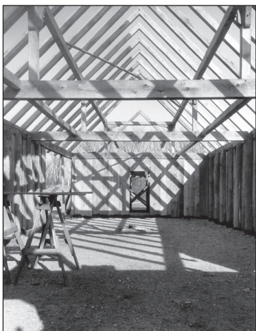
■ Obr. 7 Model domu ve Fyrkatu během stavby
