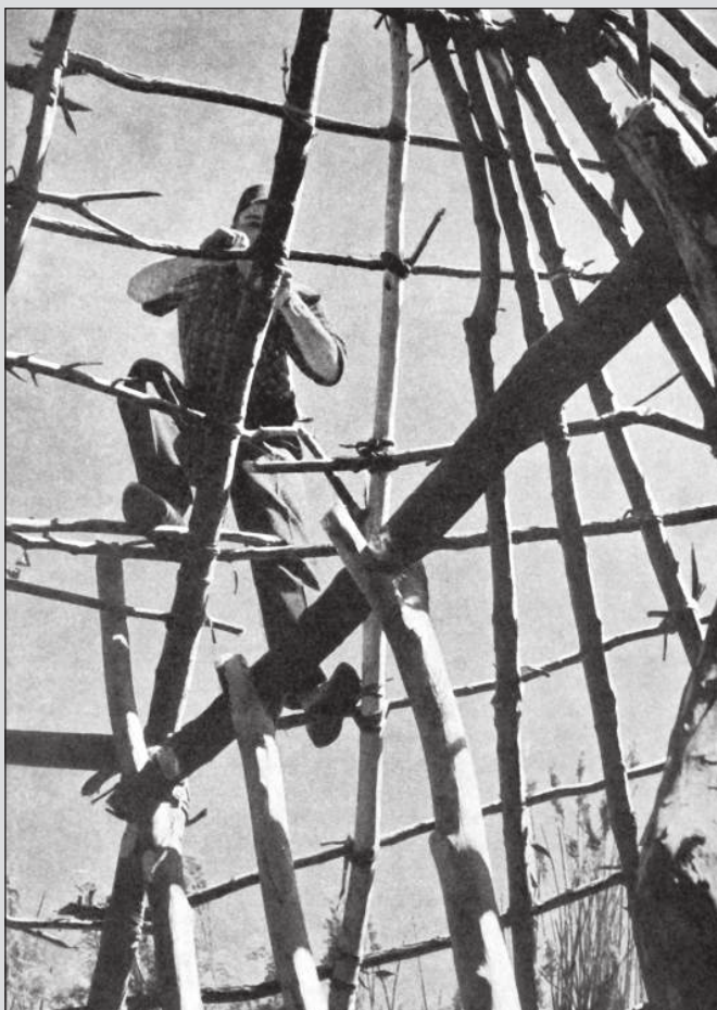
■ Obr. 3 Dokončování hrubé konstrukce domu. (Hansen 1959: „I built a Stone Age House“)
