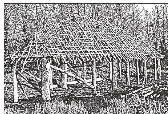
■ Obr. 11 Základní konstrukce domu z Wroxeteru.
