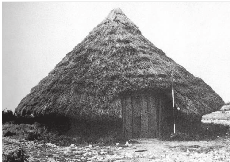
■ Obr. 1 Dům z Maiden Castle po dokončení. Konstrukce stojící na exponovaném místě v areálu Little Butser odolala i větrům o rychlosti hurikánu. Z aerodynamického hlediska má ideální tvar bez jakýchkoliv rovných ploch vystavených přírodním živlům (Reynolds 1979, 35).
