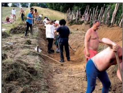
■ Obr. 3 Hloubení příkopu.
