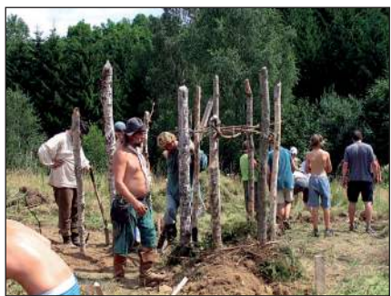
■ Obr. 2 a/b Uhřínov. Vztyčování opěrných kůlů pro koše/gabiony.
