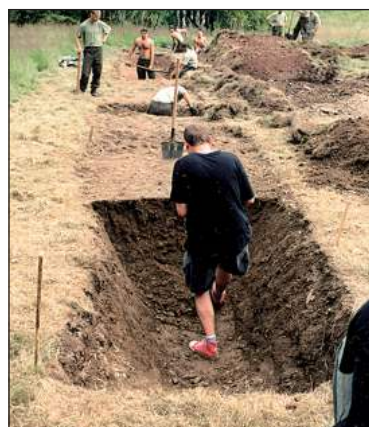
■ Obr. 1a/b Hloubení lichoběžníkovitého příkopu a celkový pohled na východní část experimentální reduty u Olbramova v létě r. 2002.
