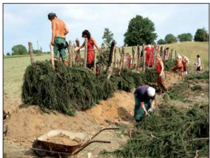
■ Obr. 4 Vyplétání a plnění košů.
