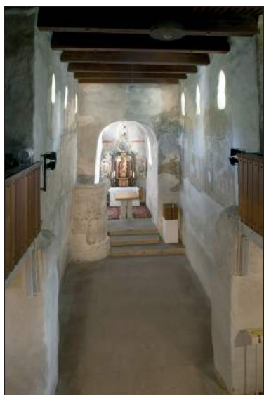
■ Obr. 4. Pohled do nejstarší části stavby před rekonstrukcí. Foto J. Gloc – M. Frouz.
