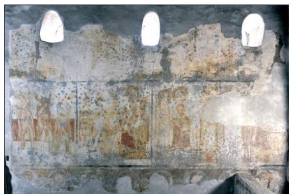
■ Obr. 6. Nástěnné malby na severní stěně lodi. Foto T. Berger.
