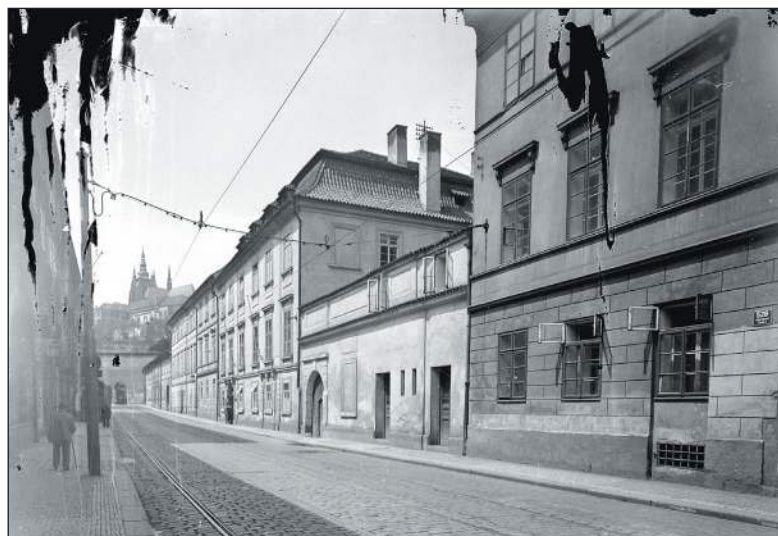
■ Obr. 2 Budova Archeologického ústavu v Letenské ul. 4 na Malé Straně. Prvním sídlem ústavu byly skromné prostory ve Strahovském klášteře, v dalších letech pak ústav sídlil v Lobkovickém paláci ve Vlašské ulici v Praze (od 1930), v domě čp. 424 na Újezdě (od 1950) a konečně v Letenské ul. (od 1951). Archiv ARÚP FT–11640, negativ poškozen při povodni v roce 2002.
