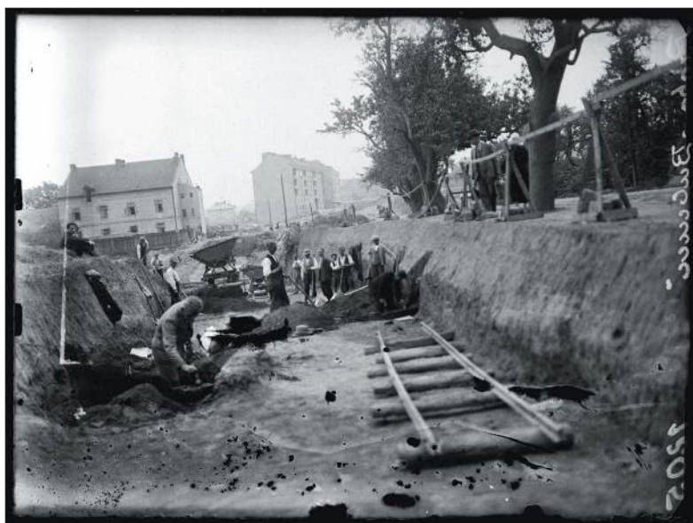
■ Obr. 5 Pohled na stavbu silnice v Praze-Bubenči, v Podbabské ulici u trati v roce 1932. Situace zahloubena do kulturní vrstvy doby římské s železářskými pecemi. Foto J. Böhm. Archiv ARÚP FT–1205.
