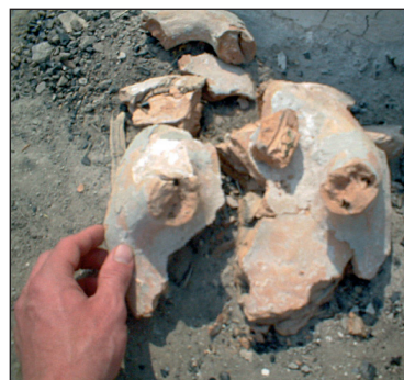
■ Obr. 3 Původní poklop se rozbil
