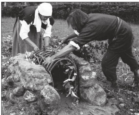
■ Obr. 3 Stavba pece - klenutí stropu z větví před omazáním mazaníc.
