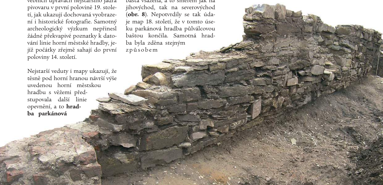
■ Obr. 10 Hradec Králové, areál bývalého pivovaru. Pohled na část opukového zdiva parkánové hradby.
