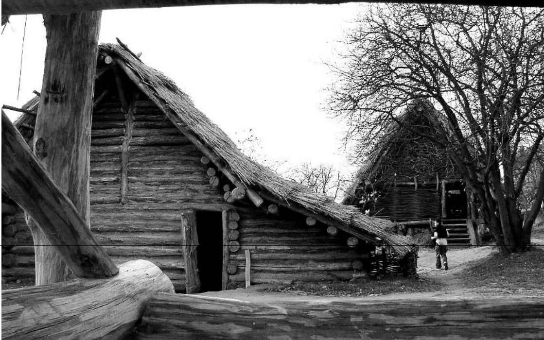
Obr. 5 Pohled na zemnici s výrobou kamenných přeslenů, v pozadí klet s funkcí spížirny a seniku. ■
