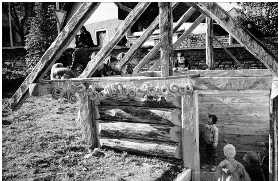
Obr. 12 Experimentální stavba objektu B7: hrubá stavba s krovem. (foto na této dvojstránce archiv Archaia) ■
