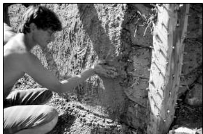
Obr. 18 Experimentální stavba objektu B7: ruční nanášení mazanice na stěnu. ■
