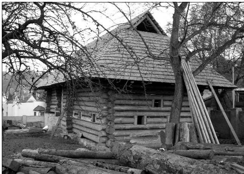
Obr. 28 Stavba trojdielného komorového domu B1: pohled na štítovou a dvorní okapovou stěnu dokončené hrubé stavby. (foto archiv Archaia) ■
