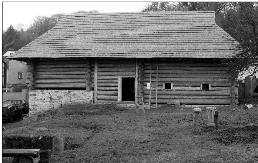
Obr. 27 Stavba trojdílného komorového domu B1: pohled z areálu parku na dokončenou hrubou stavbu se šindelovou střechou. (foto archiv Archaia) ■
