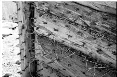
Obr. 17 Experimentální stavba objektu B7: detail stěny připravené k omazu. ■
