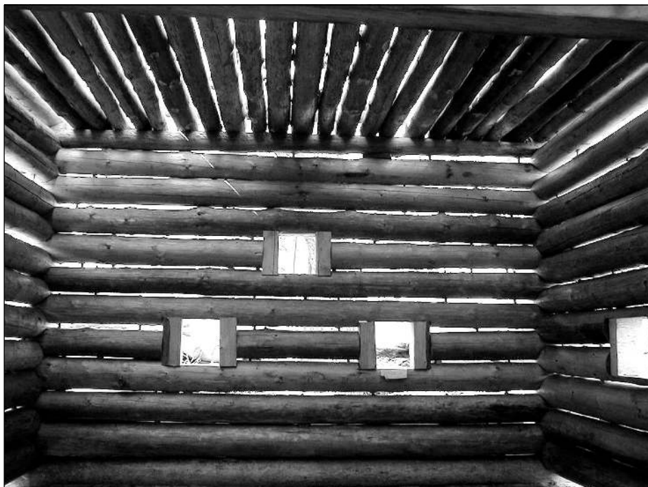
Obr. 26 Stavba trojdílného komorového domu B1: interiér jizby s pyramidovitě uspořádanými okenními otvory ve štítové stěně. (foto archiv Archaia) ■
