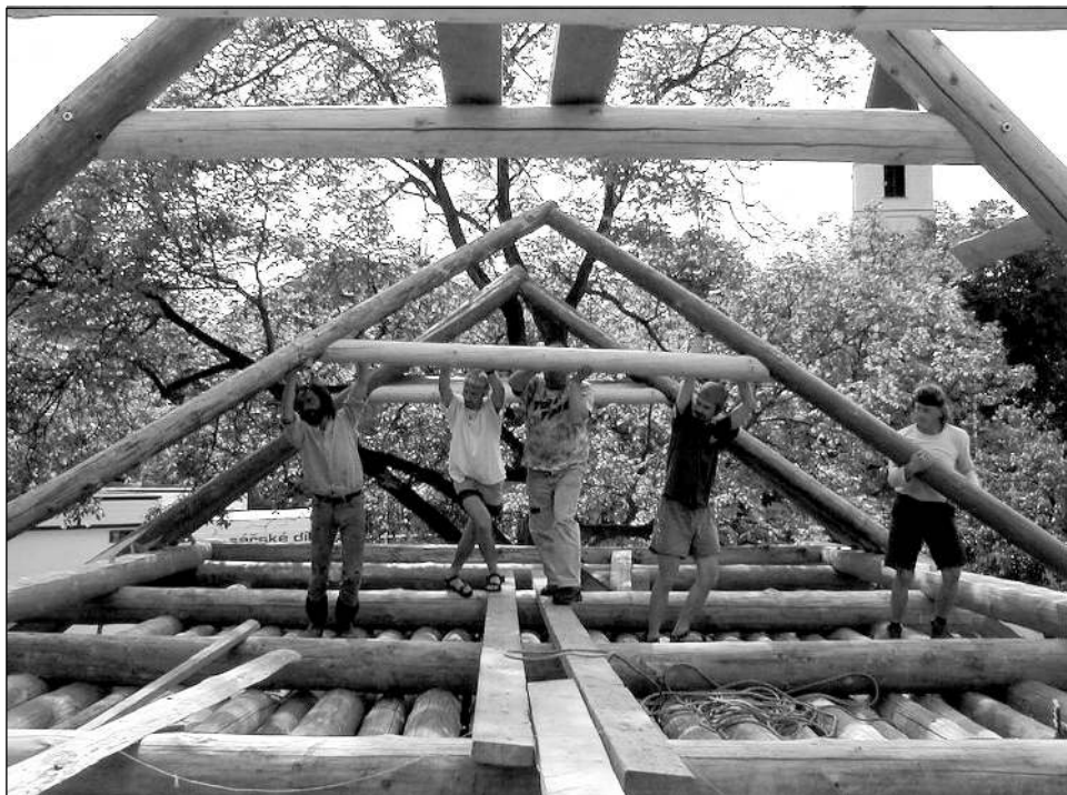
Obr. 25 Stavba trojdílného komorového domu B1: vztyčování krokrového krovu. (foto archiv Archaia) ■
