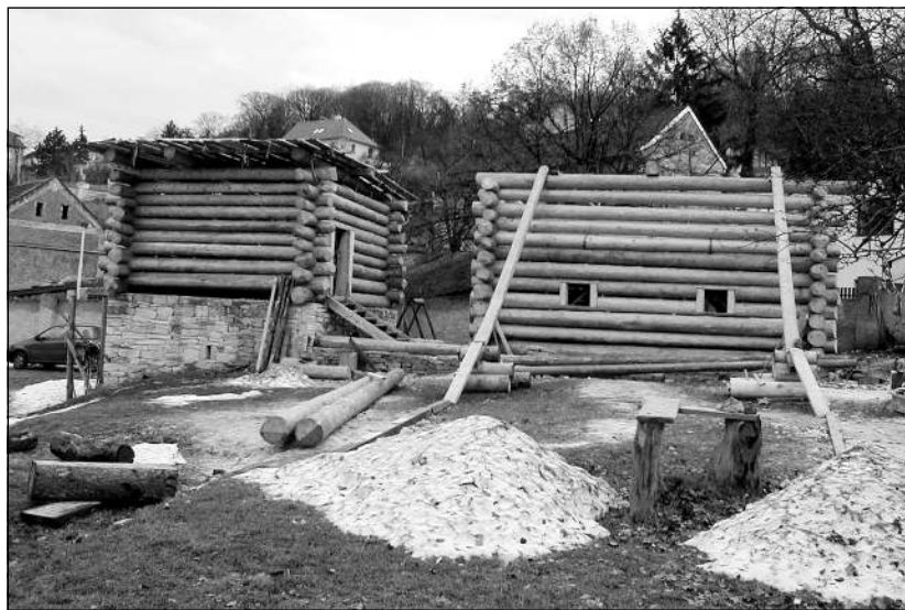
Obr. 23 Stavba trojdílného komorového domu B1: vpravo roubená jizba, vlevo spodní zděná a horní roubená komora. (foto archiv Archaia) ■
