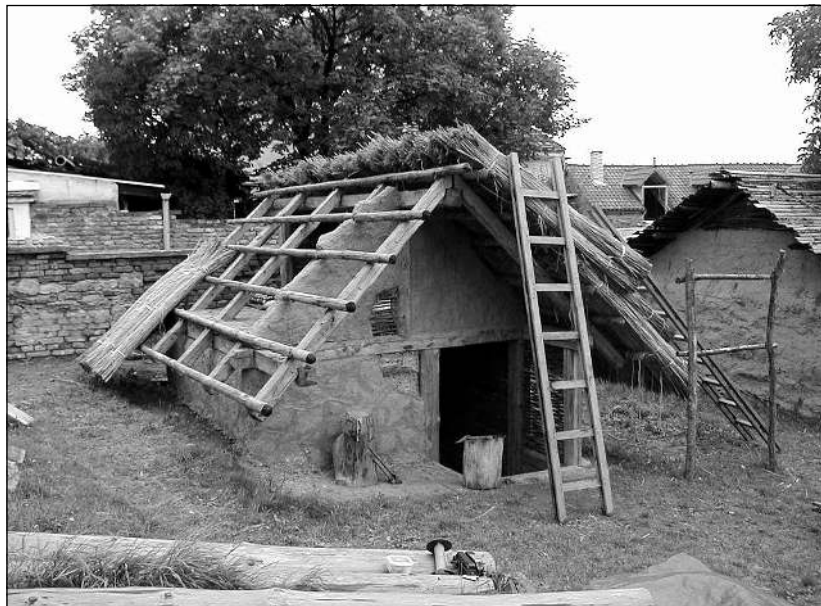
obr. 13 Experimentální stavba objektu B7 před dokončením. ■
