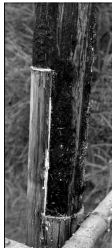
Obr. 4-6 Vycistené a vylamelované hniezdo hniloby v spoji stĺpa a priečle. ■ Nadstavenie poškodených koncov stĺpov preplátovanou protézou. ■ Revezibilné osadenie stĺpa do betónu. ■
