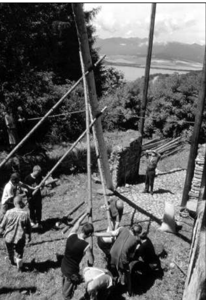
Obr. 7 Vztýčovanie nového stĺpa. ■
