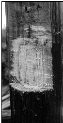
Obr. 4-6 Vycistené a vylamelované hniezdo hniloby v spoji stĺpa a priečle. ■ Nadstavenie poškodených koncov stĺpov preplátovanou protézou. ■ Revezibilné osadenie stĺpa do betónu. ■
