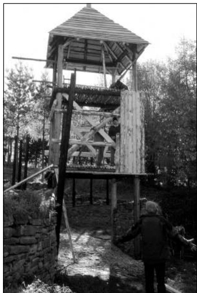
Obr. 8 Realizácia vodorovného stuženia veže v úrovni podlažia. ■
