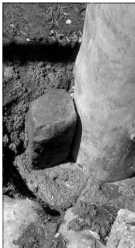
Obr. 4-6 Vycistené a vylamelované hniezdo hniloby v spoji stĺpa a priečle. ■ Nadstavenie poškodených koncov stĺpov preplátovanou protézou. ■ Revezibilné osadenie stĺpa do betónu. ■
