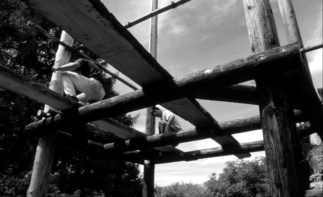
Obr. 2 Veža v štádiu hotovej rekonštrukcie hrubej stavby v lete 2003. ■
