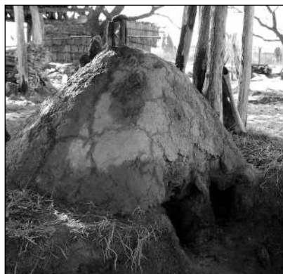
obr. 27 První verze konstrukce vertikální dvoukomorové pece. ■
