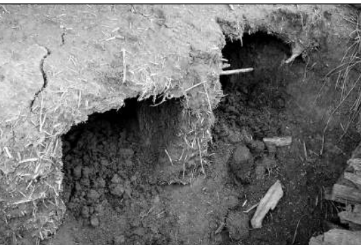
Obr. 35 Poškození vertikální dvoukomorové pece na nedostatečně kryté SZ straně přístřešku. ■
