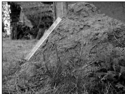
Obr. 43 Rozplavovaná vnější část pláště jednokomorové pece. ■
