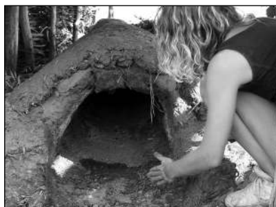
Obr. 30 Oprava horizontální pece. ■
