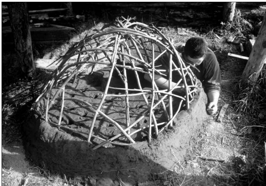
obr. 29 Kostruckce pláště vertikální dvoukomorové pece. ■
