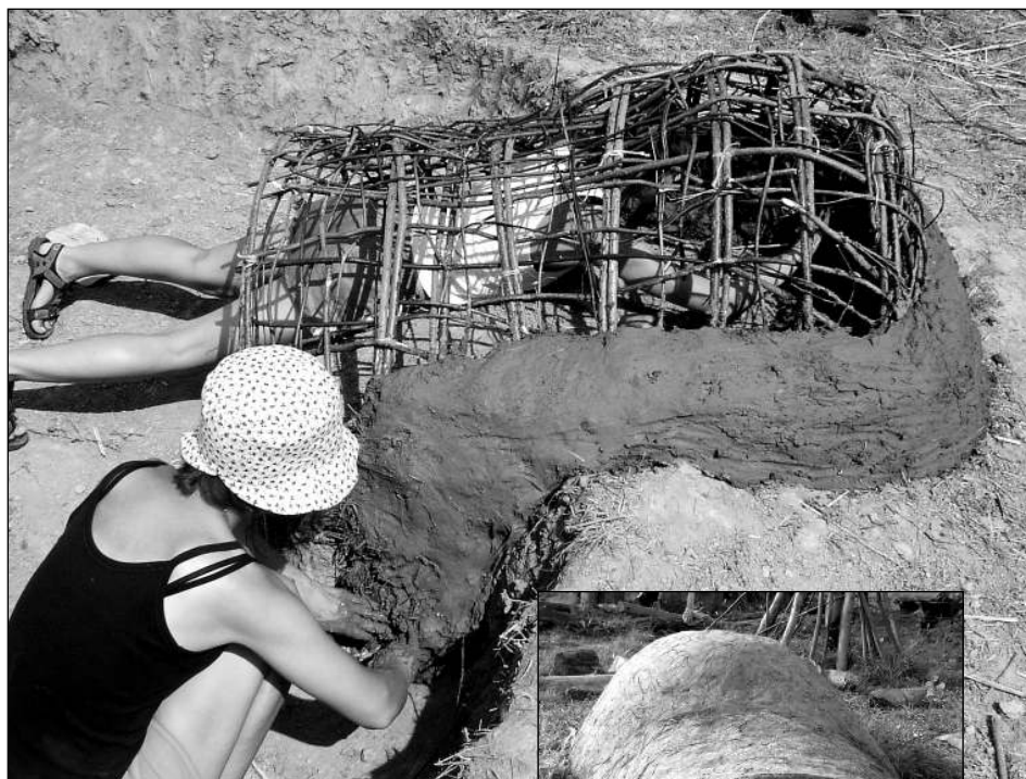
Obr. 12 Stavba jednokomorové pece. ■
