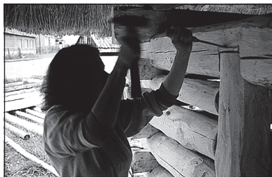
Obr. 8 Znižovanie stĺpika – dôsledok sadania rekonštruovanej drevenice. ■ Lowering of a post - result of subsiding of reconstructed wooden house. ■ Erniedrigung der Säule – Folge der Senkung eines rekonstruierten Holzhauses. ■
