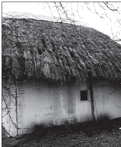
Obr. 7 Slamená krytina drevenice v Borskom Petri – 15 rokov po realizácii, avšak bez údržby. ■ Hay roofing of a wooden house in Borský Peter - 15 years after it was built, without maintenance. ■ Strohbedachung eines Holzhauses in Borský Peter – 15 Jahre nach Realisierung, aber ohne Wartung. ■
