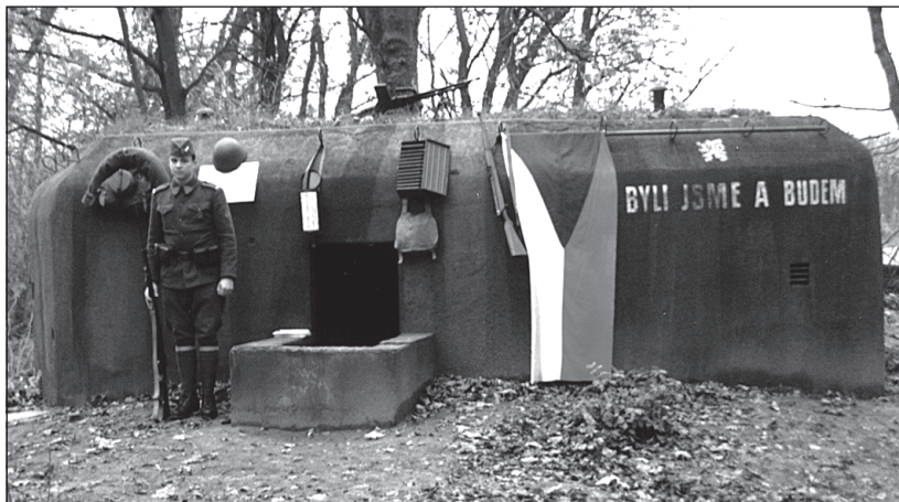
Obr. 6 Rekonstrukce jednoho z bunkrů z let 1937/38. ■ Reconstruction of the concret shelter from 1937/38. ■ Rekonstruktion eines Betonbunkers aus den Jahren 1937-1938. ■
