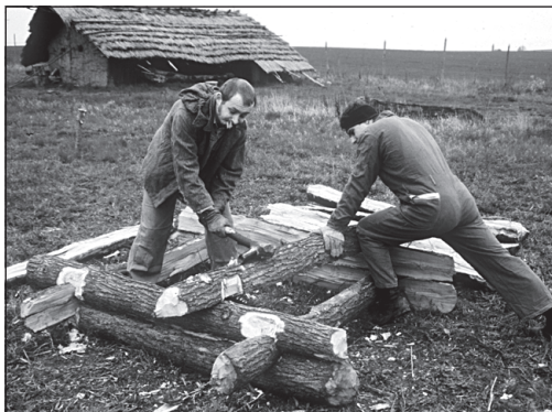
Obr. 17-18 Roubení výdřevy studny. ■ A casing of the well timbering. ■
