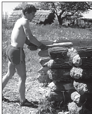
Obr. 17-18 Roubení výdřevy studny. ■ A casing of the well timbering. ■
