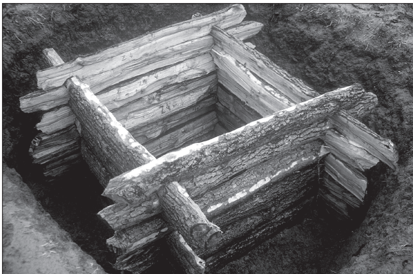
obr. 27 Vkládání výdřevy. ■ Putting in the timbering. ■
