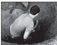
Obr. 20-23 Hloubení studniční jámy devěnými nástroji. ■ Sinking a well pit with wooden instruments. ■
