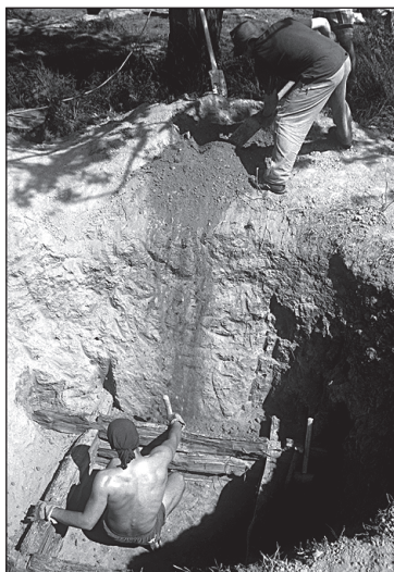
Obr. 19 Hloubení studniční jámy (každé pole uvnitř jámy představuje vrstvu odkopanou během jedné hodiny.). ■ Sinking a well pit. ■
