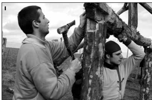
Štípání kmene dřevěnými klíny (H); začistění spojů při stavbě dřevěné konstrukce (I)
