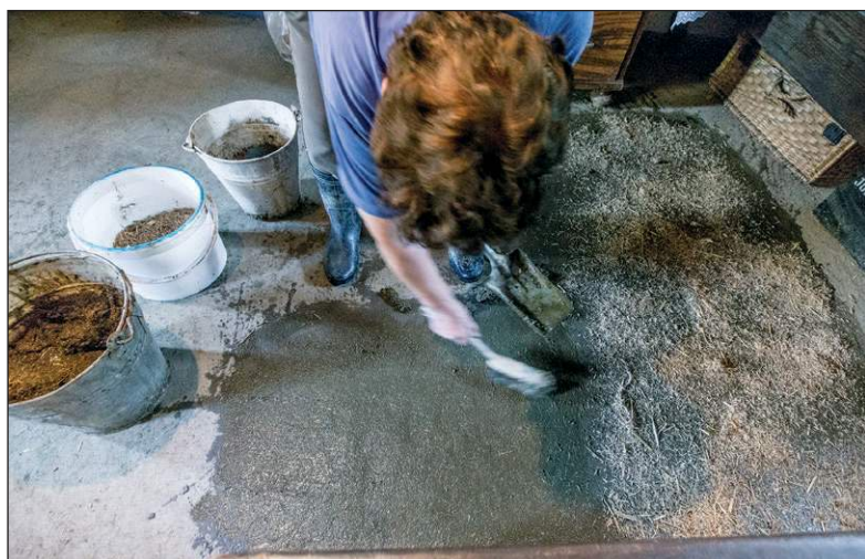
■ Obr. 2 Komponenty nutné na úpravu stávajícího povrchu a způsob aplikace (foto P. Lisý).
