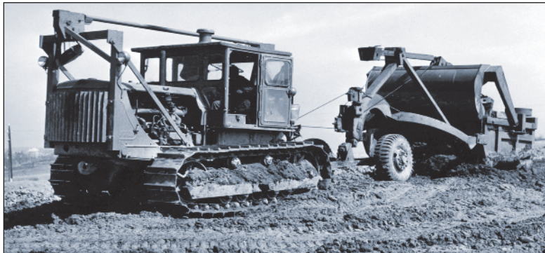
■ Obr. 2 Ve své době revoluční využití mechanizace při odstraňování ornice při výzkumu v Bylanech.
