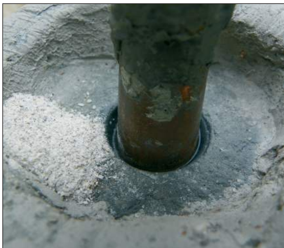
■ Obr. 18 Dávka jemného ostříva (hrubost 2) – voda odstraněna kvůli přehlednosti.
