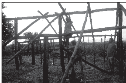
Obr. 6 Uložení nosného kůlu, pokládání „krokvice“ a uložení „stavební obětiny“. ■ Setting of a load-bearing post, fitting a rafter, depositing a building offering. ■
