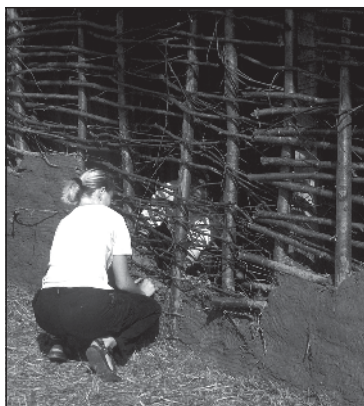
obr. 11 Práce v hlínku a omazávání stěn a štitu domu. ■ Work in the clay pit and daubing the house walls and gable. ■
