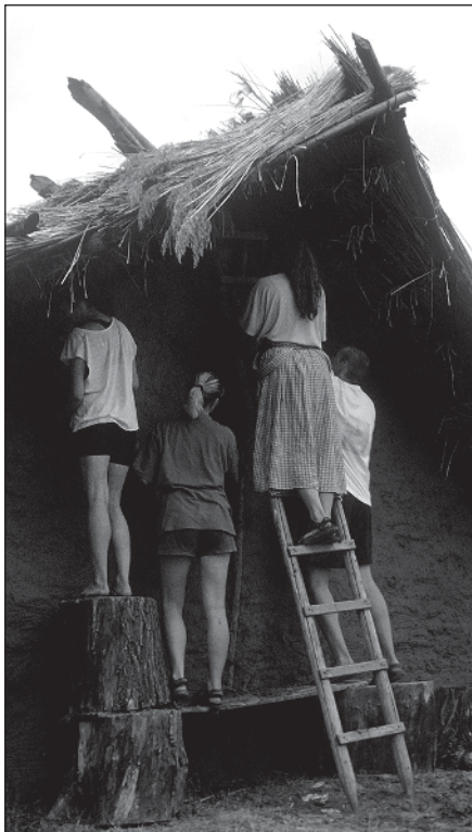
obr. 11 Práce v hlínku a omazávání stěn a štitu domu. ■ Work in the clay pit and daubing the house walls and gable. ■
