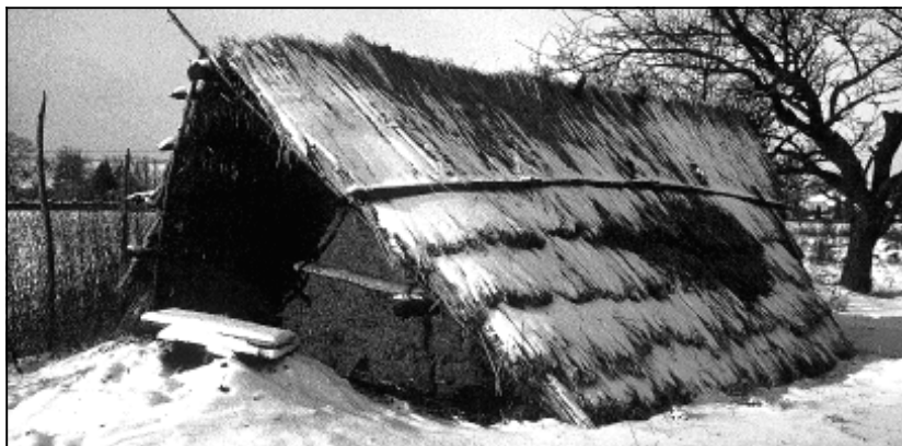
Obr. 5 Celkový pohled na rekonstrukci stavby během pokusu. Tmavá skvrna na střeše vznikla táním sněhu v blízkosti tepelného zdroje - ohniště. ■
