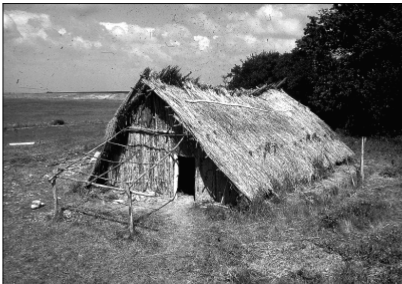
Obr. 4 Rekonstrukce domu se stavebními jámami ■
