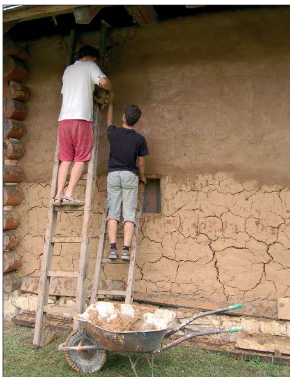
■ Obr. 6: Archeopark Praha-Liboc. Nanášení svrchní vrstvy mazanice (foto P. Netolický).
