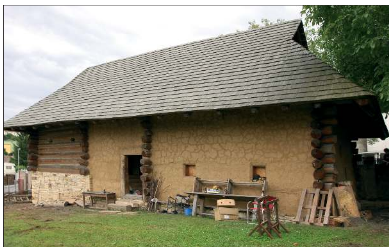
■ Obr. 7 Archeopark Praha-Liboc. Trojdílný dům s omazanou jizbou a síní. Horní komorová část je zatím opatřena pouze výmazy spár mezi kuláči (foto P. Vařeka).
