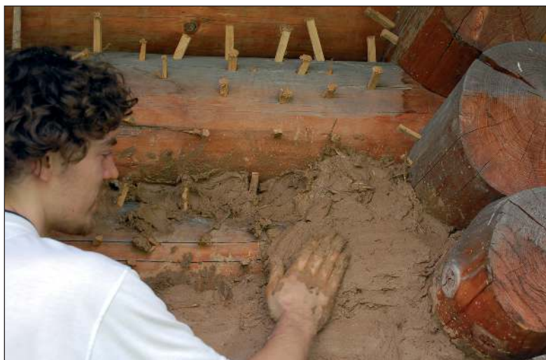
■ Obr. 4 Archeopark Praha-Liboc. Omazávání roubené konstrukce opatřené dřevěnými kolíčky (první vrstva omazu; foto P. Netolický).
