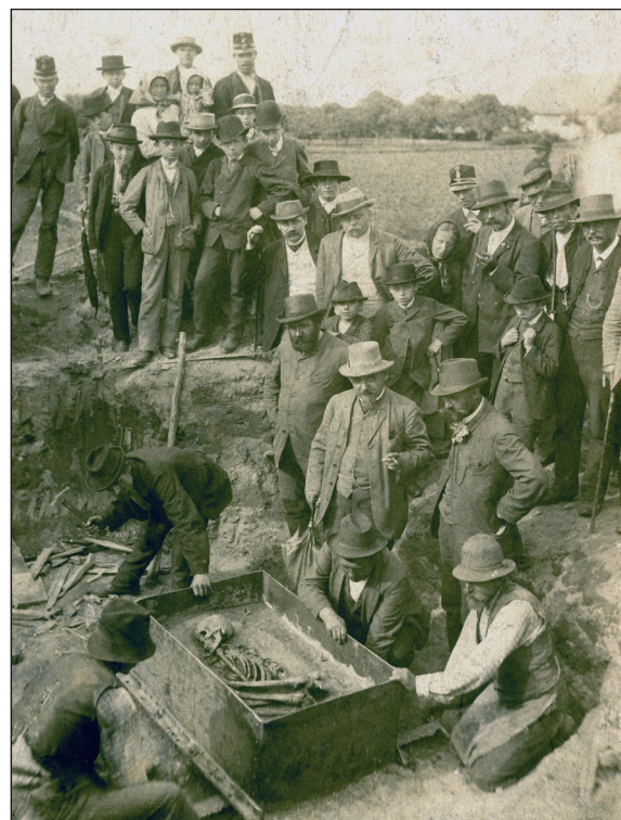
■ Obr. 1 Vyzdvižení hrobu in situ v Želenicích v roce 1892 – v přední části fotografie je dobře vidět technika vodorovného odřezávání bloku s kostrou pomocí pily (archiv OAS MMP – fond J. A. Jíra, sv. 80). Grafická úprava M. Kafka.
