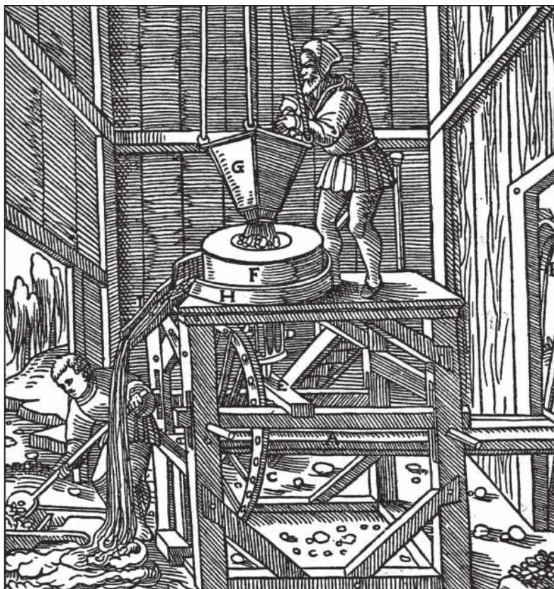
■ Obr. 9 Zlatorudný mlýn podle Georgia Agricoli (1556).
