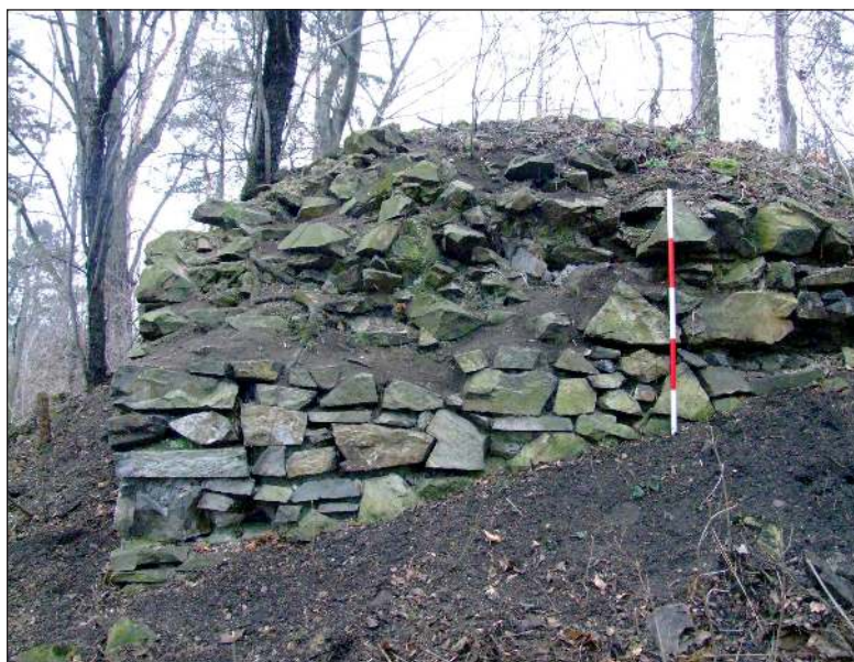
■ Obr. 11 Liběhrad, okr. Praha-západ. Dochované nároží obvodové hradby hradu. Pohled od jihozápadu.
