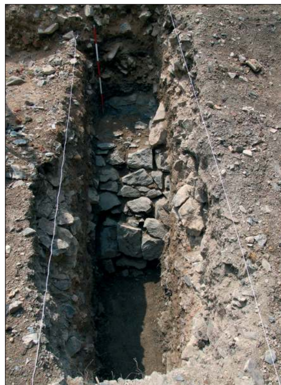
■ Obr. 7 Chvatěruby, okr. Mělník. Vyzděná eskarpa severního průběhu příkopu kopírujícího hradní jádro.
