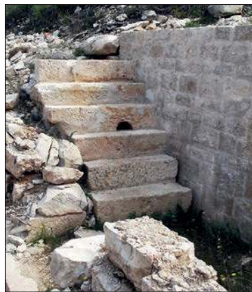
■ Obr. 9 Burnum – detail schodiště u východního vstupu
